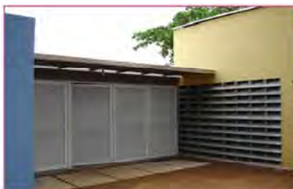
Fachada al patio interno VBP-1. Cedida por Dr. Arq. Eduardo González Cruz
