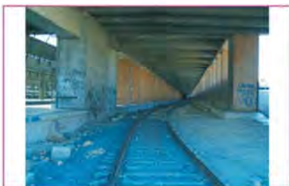
Imagen de la vía actualmente en desuso a su entrada por el norte a la estación de Santa Justa fuente: propia
