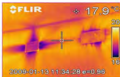
15. Imagen termográfica instalaciones EFICACIA
