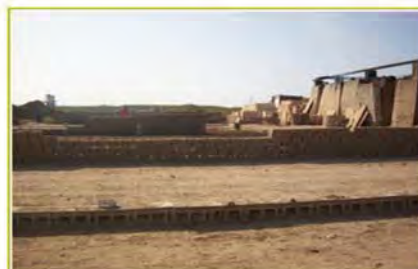
Vista de Aljarasur Elaboración propia
