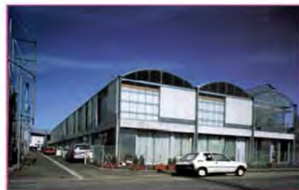
Lacaton & Vassal: Viviendas en Mulhouse (2005) http://www.lacatonvassal.com/index.php?idp=19
