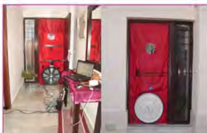
7. Ensayo de presurización. Fuente propia
